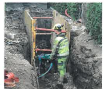
Arbejdet udføres under trange pladsforhold.
