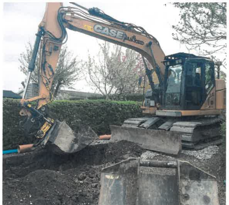
Udgravning til hovedledning.
